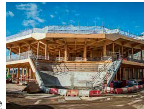
▲ Dank Vorfertigung konnten die Einzelteile binnen kürzester Zeit montiert werden
