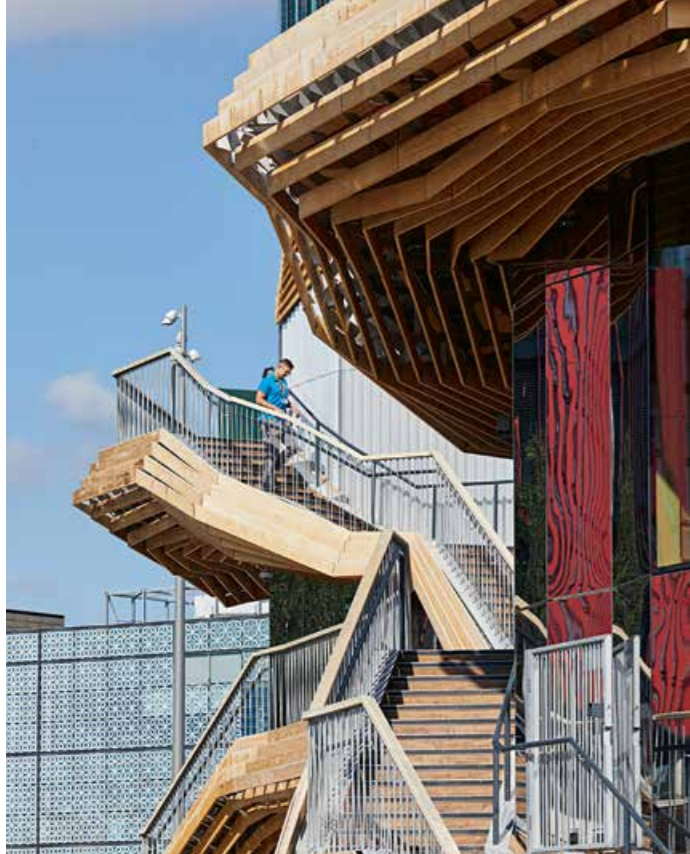
▲ Das Holz der Fassadenlamellen musste lediglich mit einer Brandschutzbeschichtung behandelt werden und ist weitgehend wartungsfrei
