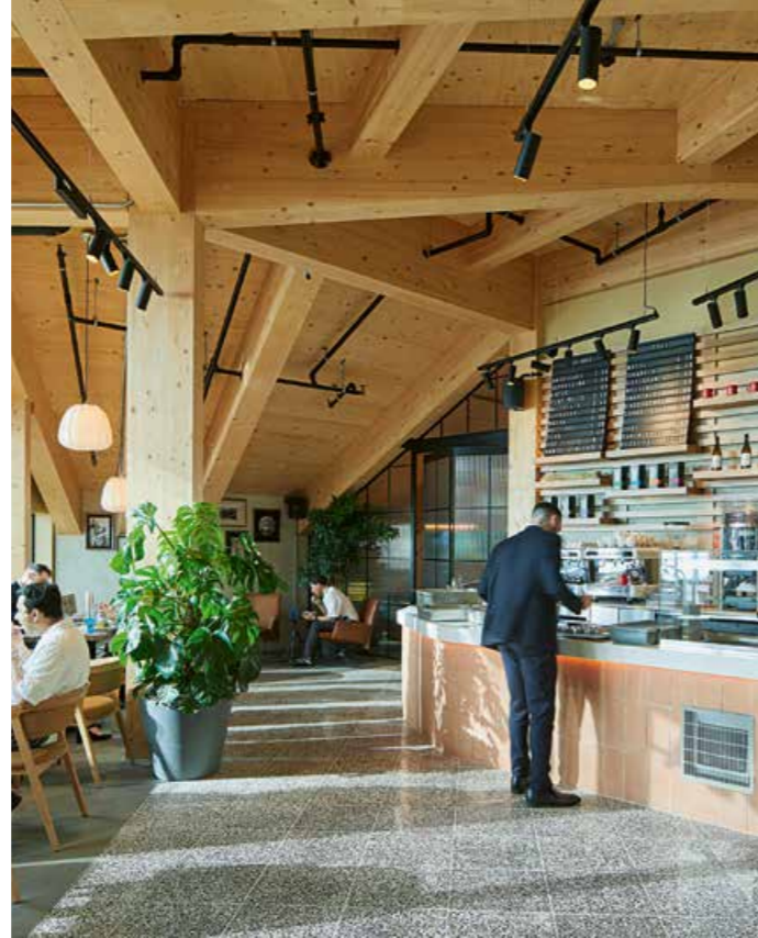
▲ Die leichte Holzkonstruktion kombiniert Brettspertholzplatten und Brettschichtholzträger
