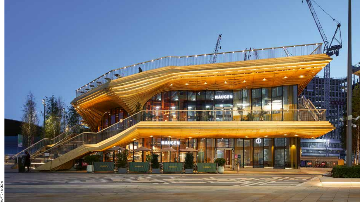
▲ Die weitgehend verglaste Außenhaut des IQL-Pavillons in Stratford lässt tagsüber viel Tageslicht in die Räume strömen. Nachts strahlt der Baukörper von innen heraus
