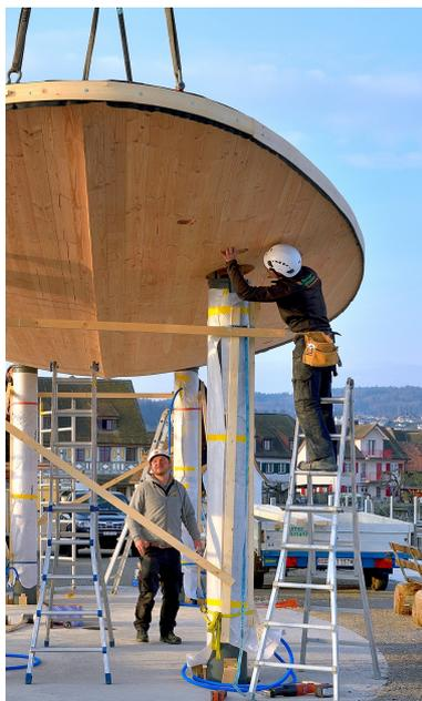
Dank Montageschablonen und passgenau produzierter Stahlstützen liess sich das Dach problemlos aufsetzen.
